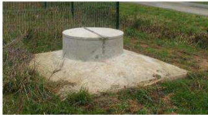
Figure 10 : Tête de forage avec dalle de protection en béton et capot étanche
